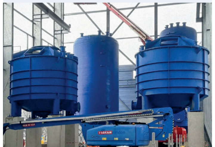
BTA-Vorbehandlung in Gennevilliers während der Installation
